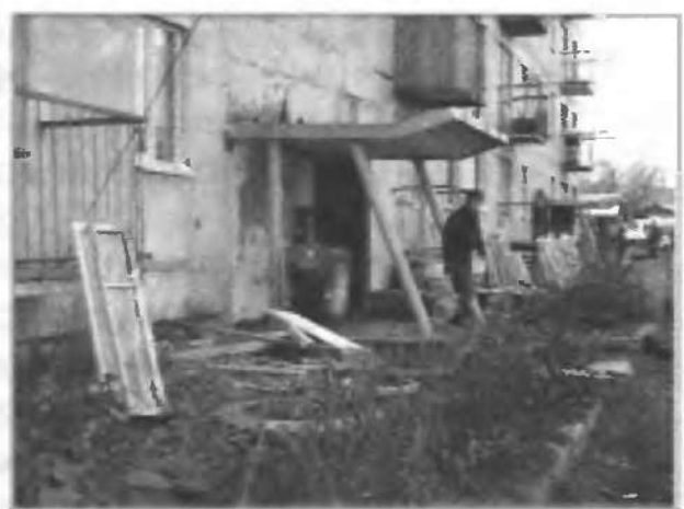
Последствия взрыва склада боеприпасов в п. Южные Коряки. Были разрушены несколько домов. Камчатка, октябрь 2005 г.
